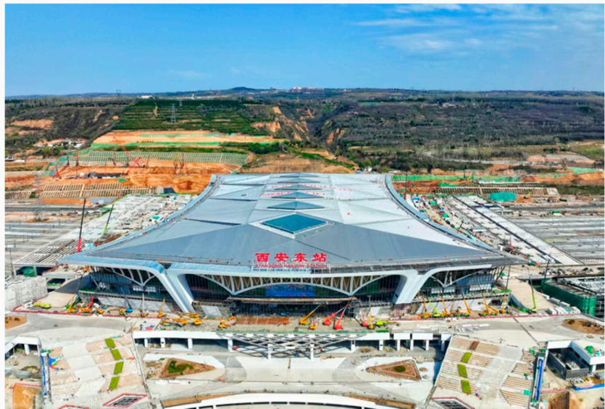
建设中的西安东车站房全景图 曹国锋 摄
