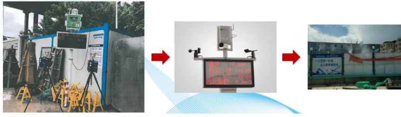
图5-16 智慧工地—扬尘监测
